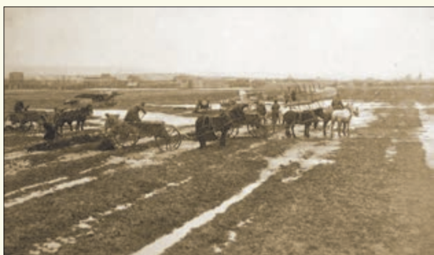
Budowa lądowiska w Krośnie 1 stycznia 1915 rok ( http://joemonster.org/art/29696/Rosyjski_korpus_powietrzny_na_ziemiach_polskich )
