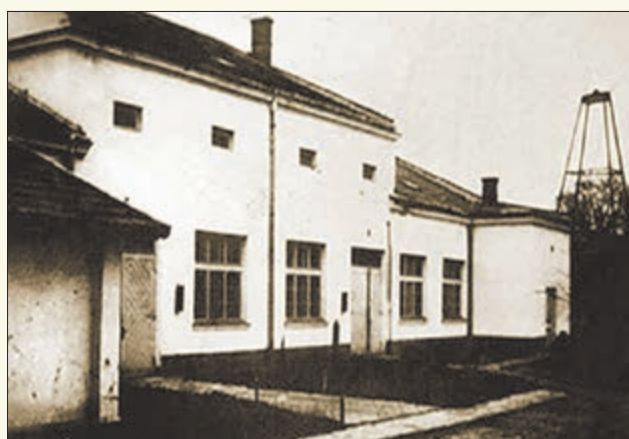
Budynek Instytutu Naftowego w Krośnie przy ul. Lewakowskiego, po prawej budynek laboratorium chemiczno – gazowego ( http://www.70lat.inig.pl )
