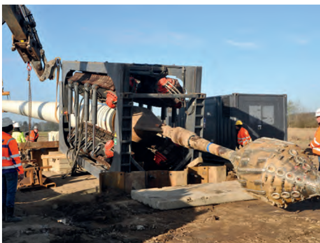
Na zdjęciach przedstawiono wprowadzenie rurociągu DN1000 do otworu wiertniczego Fot. arch. GAZ-SYSTEM S.A.
