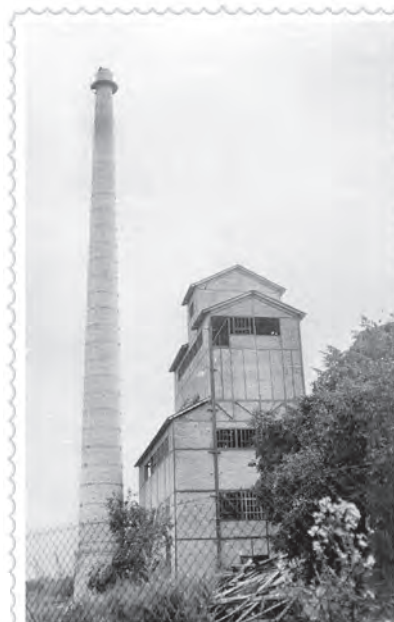
56-metrowy komin z galerijką (1960 r.), wyburzony w 1992 r. Fot. arch. WSG
