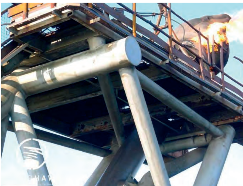
Inspekcja elementu wiertni (Copyright Cyberhawk Innovation Ltd.)
