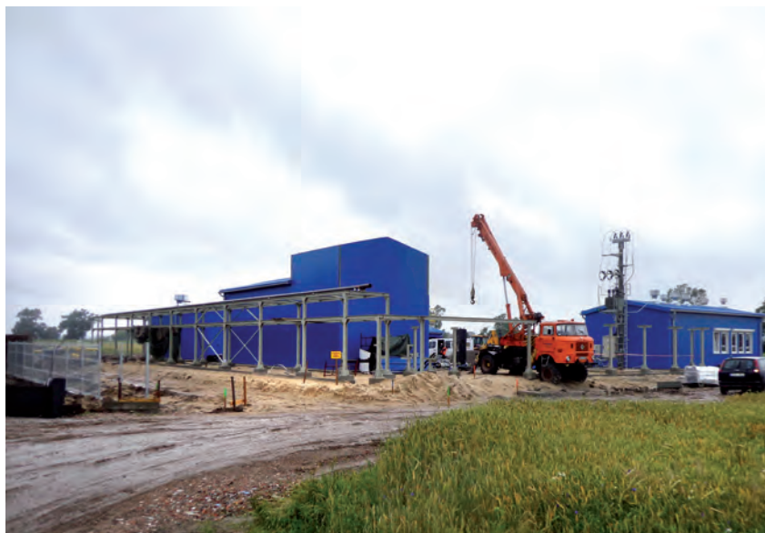
Będący w budowie Ośrodek Grupowy Lisewo został zaprojektowany w sposób umożliwiający podłączenie kolejnych stref przyodwiertowych w przyszłości. Fot. Piotr Kaczmarczyk
