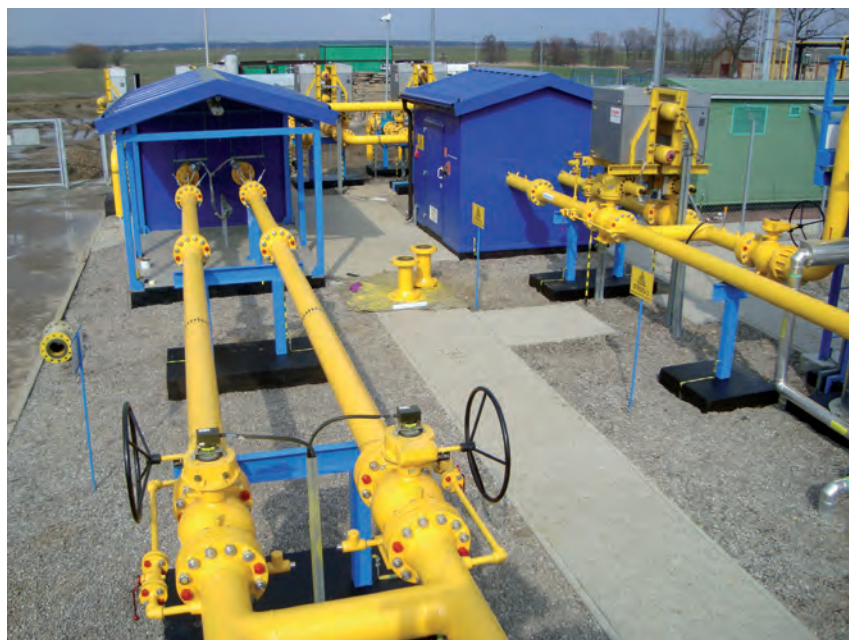
Generalnym Wykonawcą zadania „Rozbudowa Węzła Kościan” była firma PGNiG Technologie S.A. Oddział Naftomontaż w Krośnie. Fot. Marcin Kamycki
