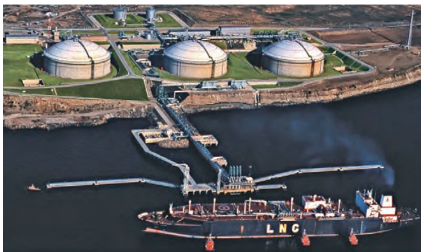
Terminal LNG Marmara Ereğlisi. Źródło: www.tmg.org.tr
