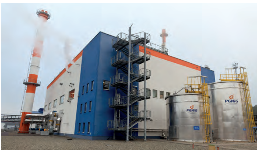
KRNIGZ Lubiatów posiada własny blok gazowo-parowy oparty na gazie ziemnym produkowanym przy wydobywaniu ropy naftowej. Fot. Sebastian Rzepiel
