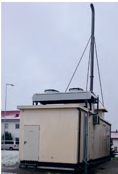
Aggregat prądowłóczy z silnikiem spalinowym na gaz ziemny towarzyszący wydobywaniu ropy naftowej stanowi po rozbudowie KRNIGZ Zielin podstawowe źródło prądu dla kopalni. Fot. Bartosz Klecha
