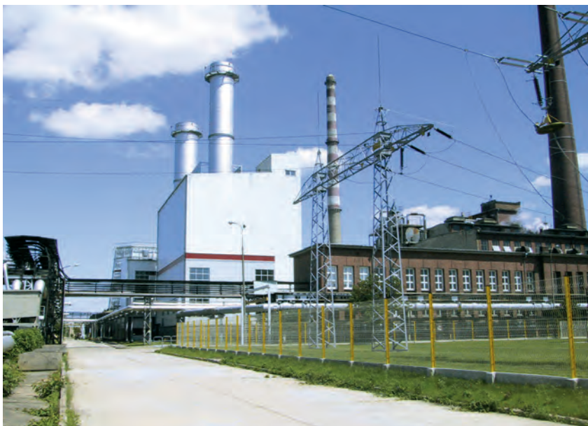
Główny odbiorcą gazu z KRNIGZ Dębno jest Elektrociepłownia Gorzów Wlkp., która jednocześnie jest dostawcą części energii elektrycznej niezbędnej do funkcjonowania kopalni. Fot. EC Gorzów Wlkp.
