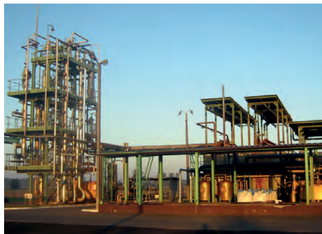
Instalacja odsiarczania metodą IGNiG – Chelate. Fot. arch. PGNiG SA Oddział w Zielonej Górze
