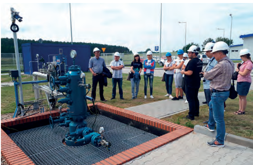
Członkowie Koła Zielona Góra na terenie KRNiGZ Radoszyn obejrżeli węży wlotowe, agregaty prądotwórcze, kotłownię, sprężarki gazu oraz instalacje stabilizacji i odsalania ropy naftowej. Fot. Joanna Inglot
