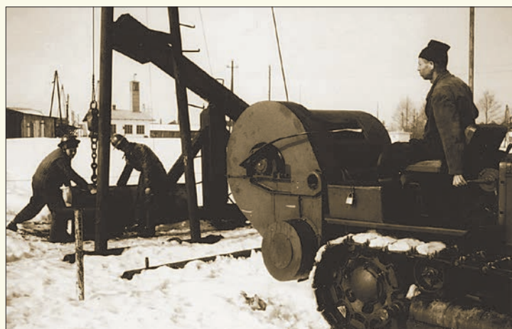
Obróbka odwiertu z windy „Mazur D-50” na kop. Turaszówka (fot. arch. Fundacji Bóbrka)
